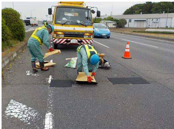
クラック補修マットの施工状況
