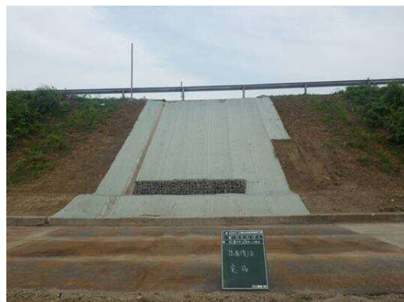
法面災害復旧完成
